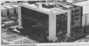
LO STABILIMENTO ST MICROELECTRONICS
